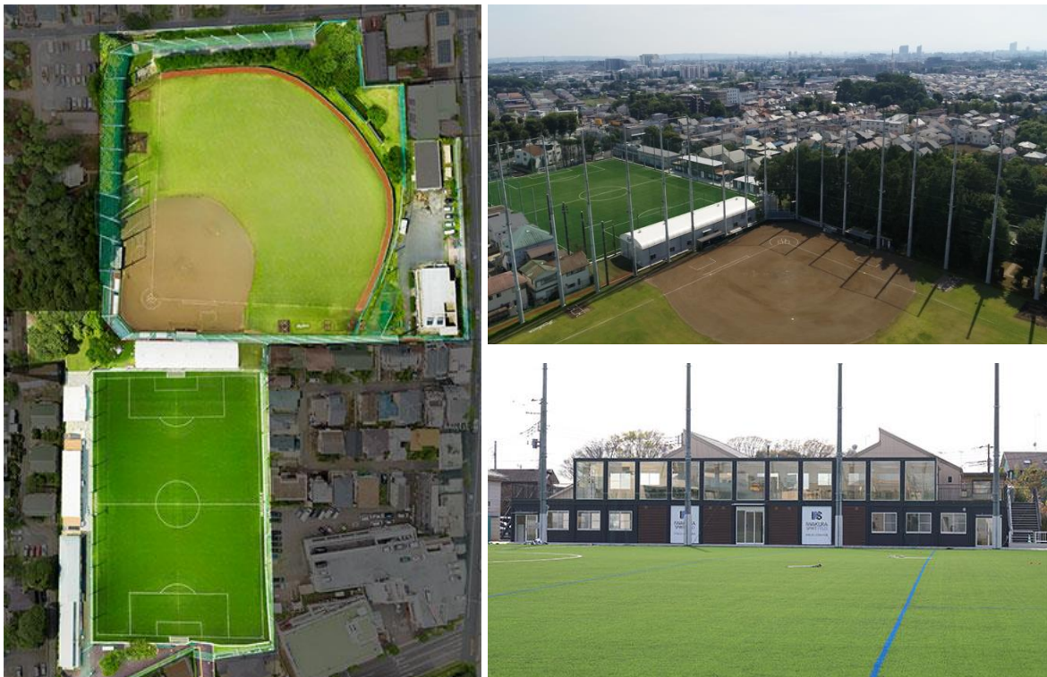
写真 4 2024 年改修後の西東京グラウンド全景
